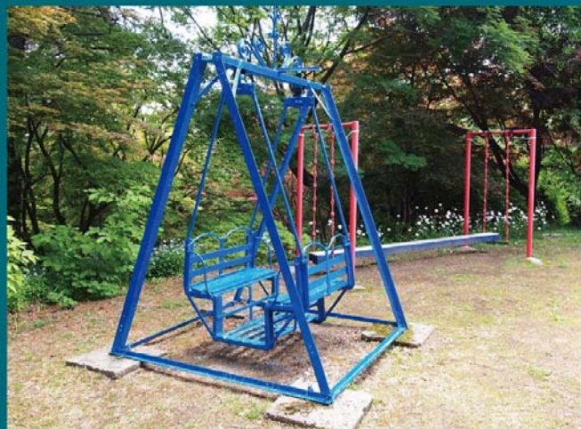
毎年ペンキを塗り重ねているので、約80年経ても現役のまま使用できる
